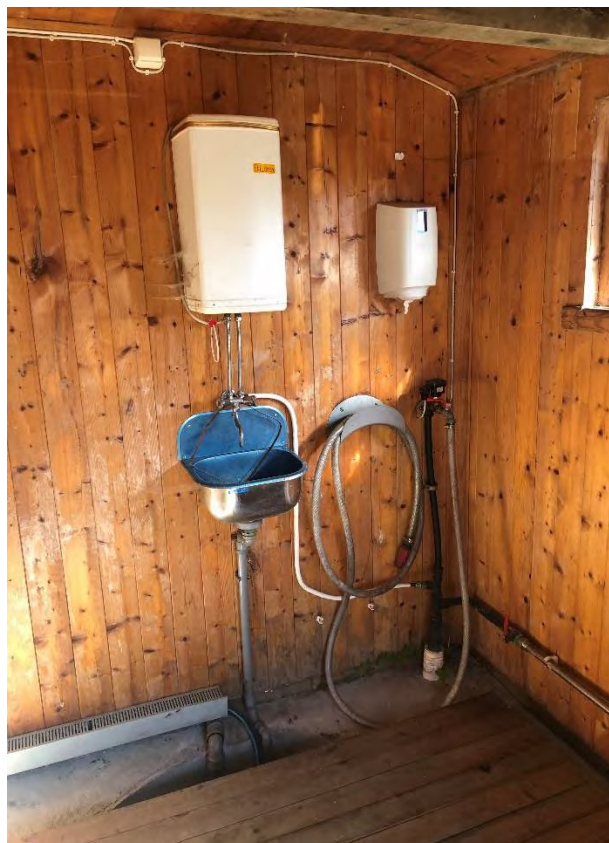
Figur 10 - Eksempel fra arbeidsforhold i en eldre pumpestasjon
