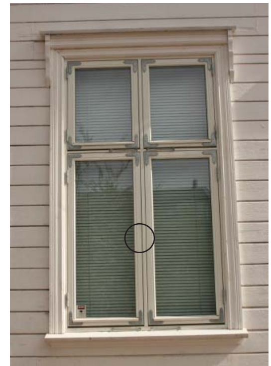
Krysspostvindu hvor hengsler skal males. Legg merke til glasslistene
