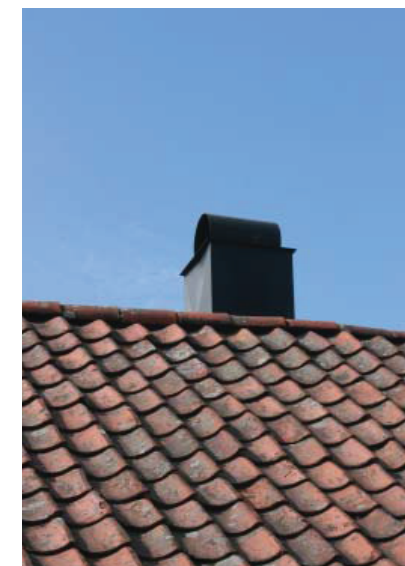
Heldekkende beslag på pipe
