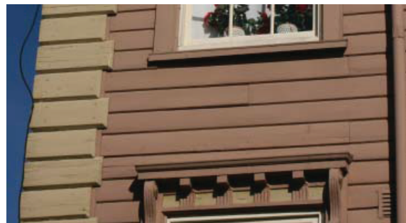
Museet i Lillesand har liggende profilert panel med mursteinsimitasjon på hjørnet
