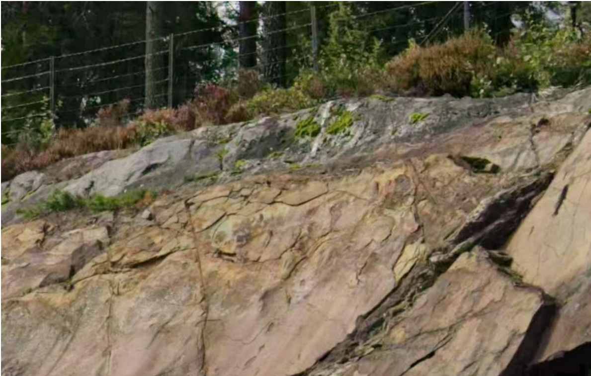
Figur 18. Bilde av skjæring like sør for Brokelandsheia. Bergarten viser mange av de samme kjennetegnene som den mest problematiske bergartstypen fra Lillesandsområdet, med gulbrun omvandlingshud, og omvandlingslag. Bilde fra Google Maps.
