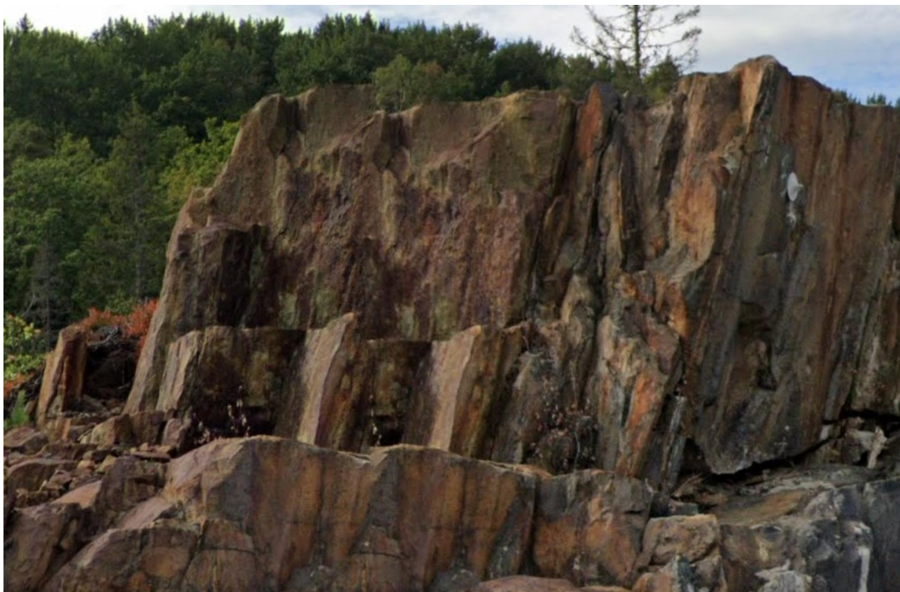
Figur 20. Fra nye E18 mellom Arendal og Tvedestrand. Rusten bergart med tydelig gulbrune utfelling. Bilde fra Google Maps.
