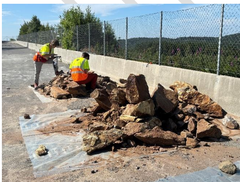
Figur 21. Steinmassene plassert på "rigg"-plass for XRF-analyser før sortering, knusing og plassering i IBC-containerer.
