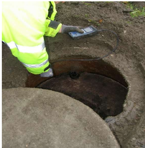
Tilsyn av slamavskiller ved Grimevann
